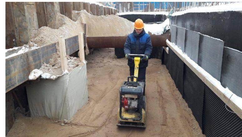
Применение технологии «жидкий грунт» в альтернативу существующей с применением механического уплотнения более эффективно в непосредственной близости со строением или сваями, а также гарантированно предохраняет гидроизоляцию от повреждений.
