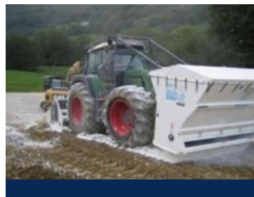
Распределение вяжущего
