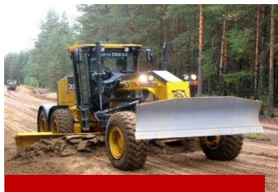
Предварительное выравнивание
